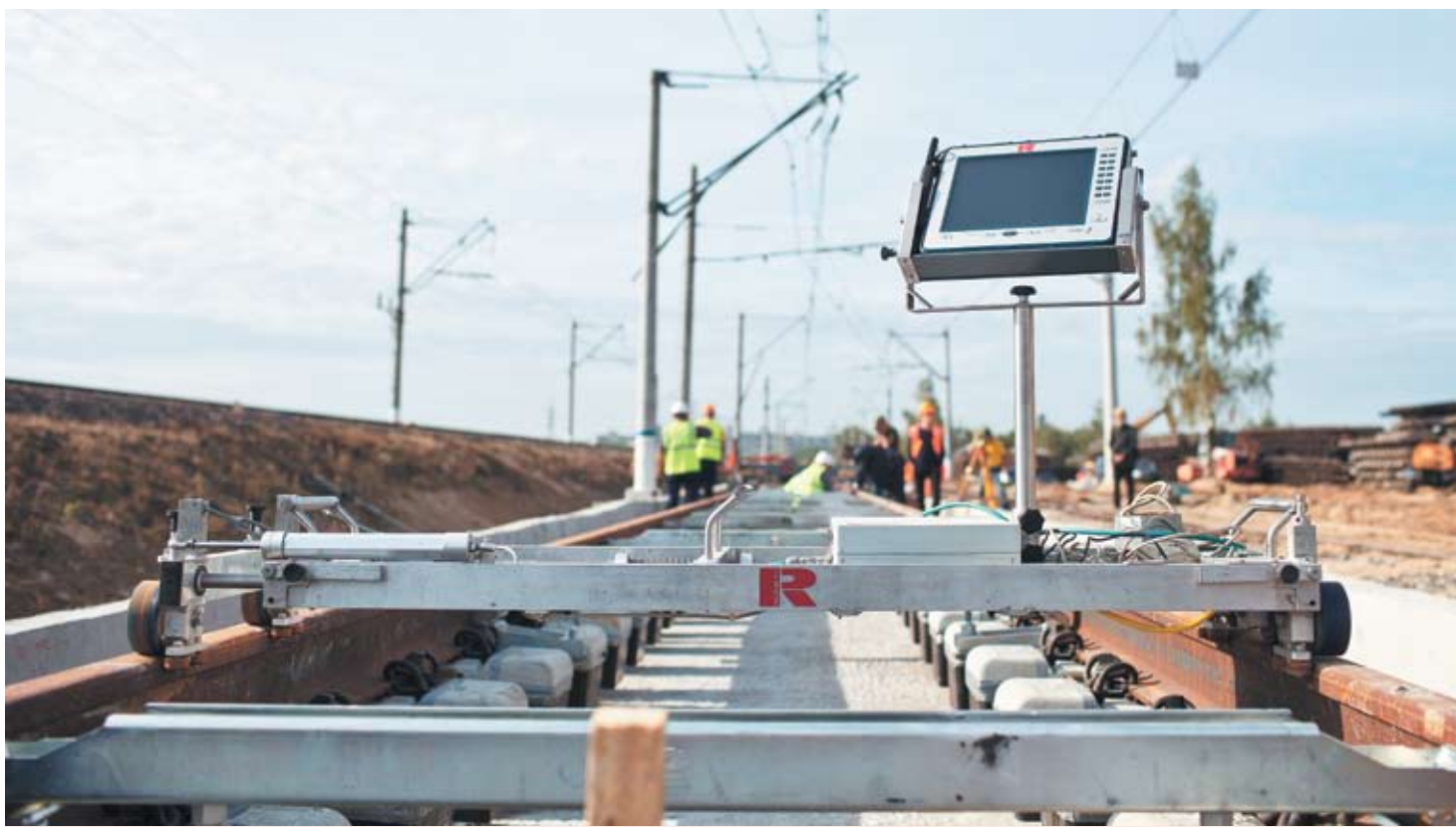
ОАО «РЖДстрой» обладает самым современным оборудованием по контролю точности выставления пути – погрешность составляет десятые доли миллиметра
